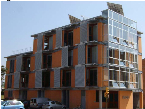
Figure 8 Ecoedifici of La Vola
